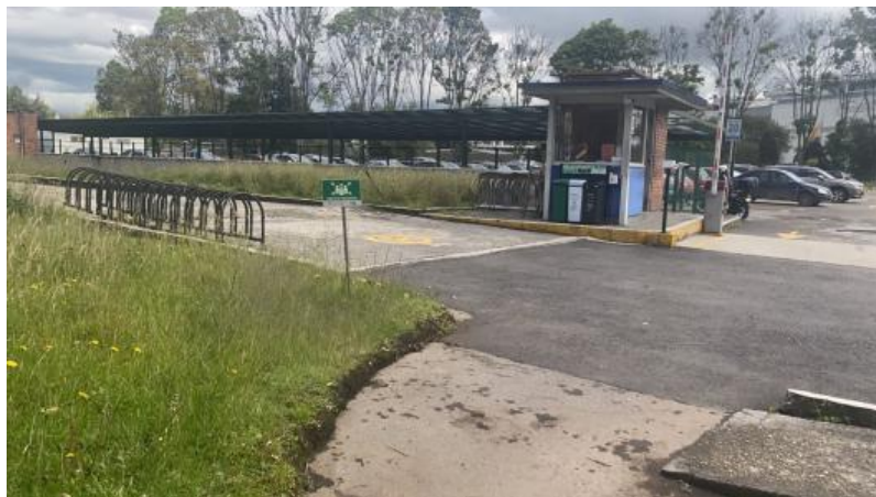
Punto 1: Parqueadero visitantes
