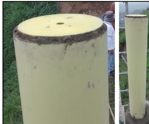
Ilustración 8. Plato de acero de 1" x 6" (rosca hembra en el centro de 5/8").
