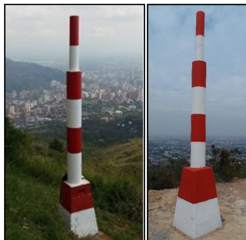
Ilustración 9. Materialización tipo obelisco terminada.
