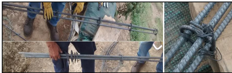
Ilustración 2. Armado hierro, base plato de acero (rosca hembra en el centro).
