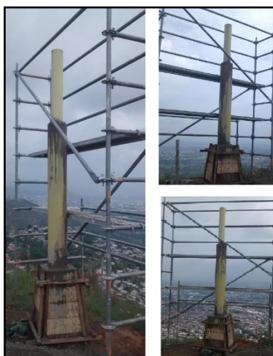
Ilustración 6. Armado cilindro 2, tubo PVC (1,2 m x 6").
