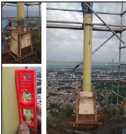
Ilustración 5. Armado cilindro 1, tubo PVC (3 m x 10").
