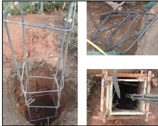
Ilustración 3. Armado estructura y encofrado prisma rectangular recto y tronco de pirámide.
