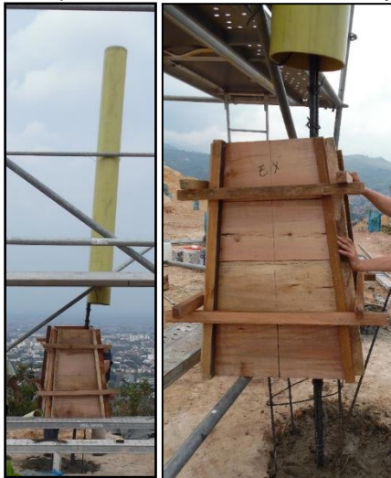
Figura 20. Vista perfil hincado varilla de hierro y tubo PVC.
