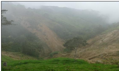
Figura 26. Erosión muy severa
